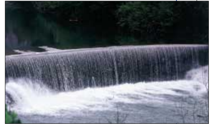
Sopra la cascata artificiale a sud di Isolabona costruita per la forza motrice della cartiera Archivio LA GAZZETTA DI ISOLABONA
