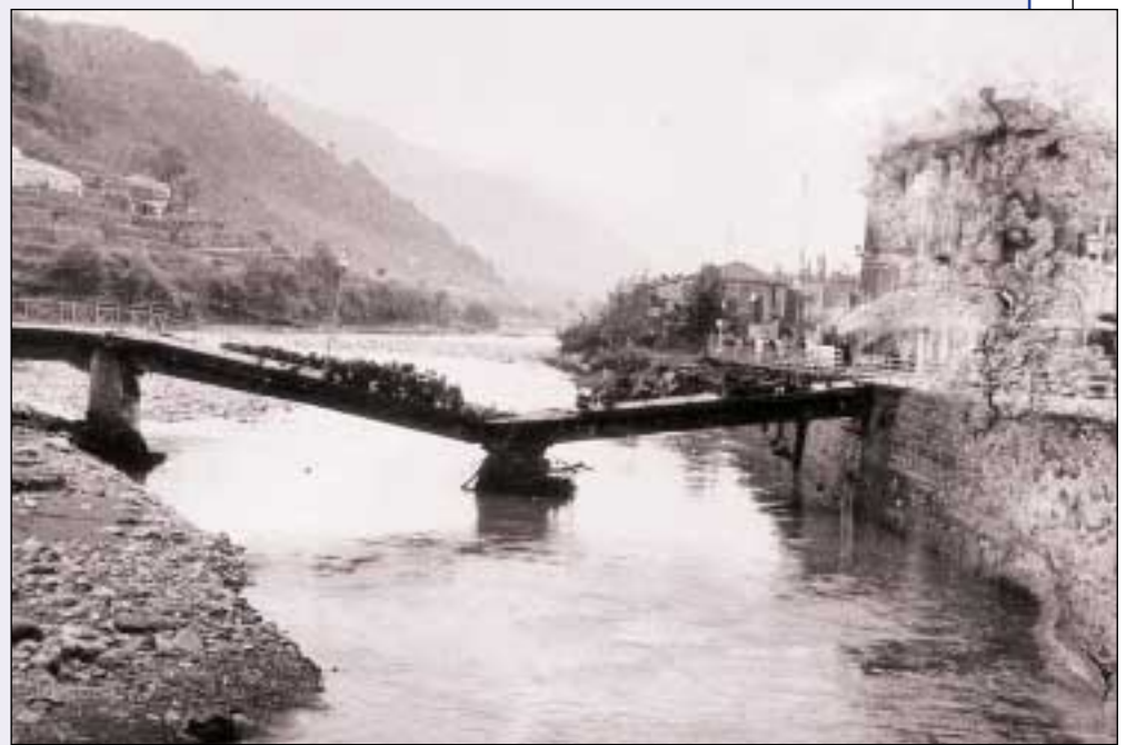
Il ponte di Dolceacqua distrutto dall'alluvione del 1966 Archivio LA GAZZETTA DI ISOLABONA
